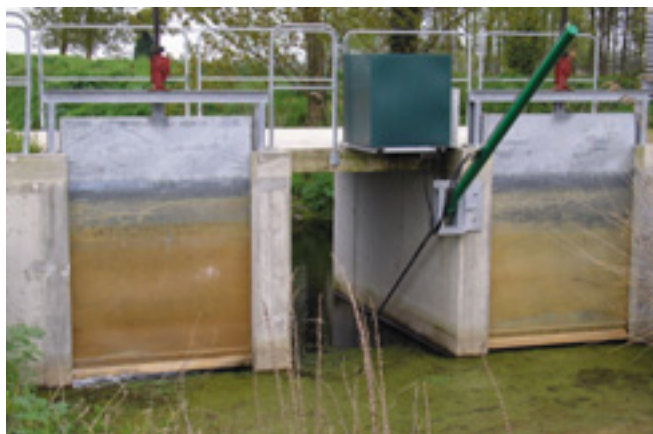
Vannage de Saint-Guinoux.
